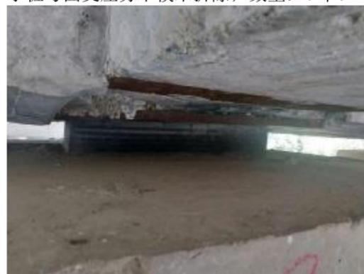
图 3-21: 锦水大桥(上行) ZZ11-4 支座: 小桩号面脱空; 数量: 1 个, 高度: 0m, 百分比: 20%。
