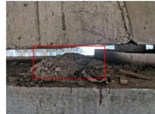
图 3-15: G324 分离立交 (下行) GL-9D 盖梁: 距右侧 5m 处, 距上缘 0m 处, 大桩号面垃圾堆积; 数量: 1 处。
