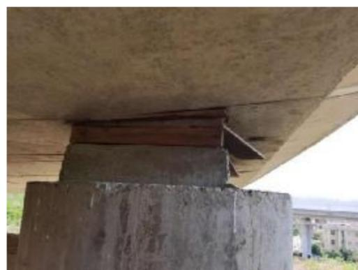
图 3-19: 塔埔枢纽 B 匝道桥 ZZ4-4-1 支座: 小桩号面支座旁木模未拆除; 数量: 1 个。
