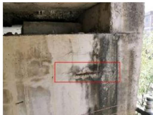
图 3-17: 锦水中桥(下行) GL-5D 盖梁: 距右侧 0m 处, 大桩号面露筋; 数量: 1 处, 长度: 0.4m。
