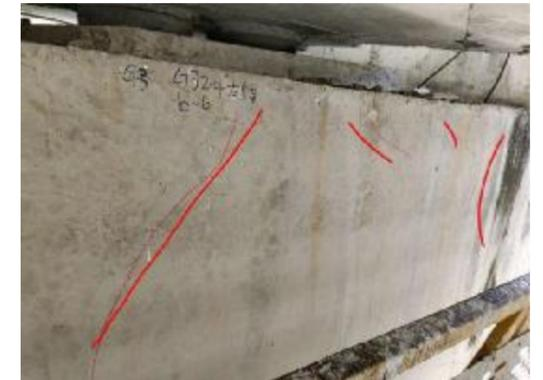
图 3-16: G324 分离立交 (上行) GL-6D 盖梁: 距右侧 1m 处, 大桩号面竖向裂缝; 数量: 4 条, 长度: 1m, 宽度: 0.2mm。
