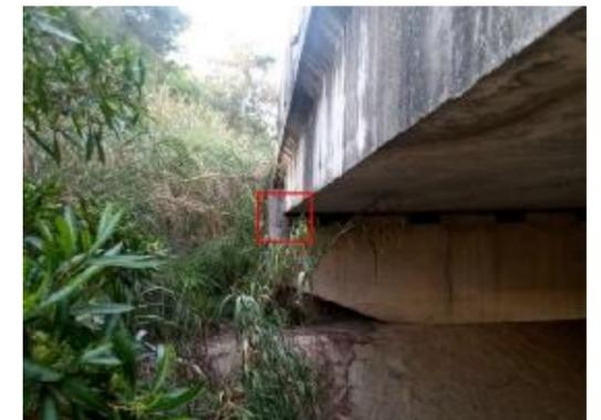
图 3-14: 上曾中桥 (上行) GR-1D 盖梁: 右侧挡块挡块抵死; 数量: 1 处。
