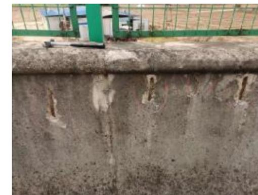
图 3-24: 坝内 1#中桥(上行) HL-R-1 栏杆、护栏: 右侧露筋; 数量: 7 处, 长度: 0.3m。
