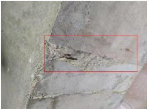
图 3-8: 坝岭大桥 (上行) 4-7T 梁: 距 3 号墩 6m 起, 右翼缘板渗水泛碱; 数量: 2 条, 长度: 0.1m。
