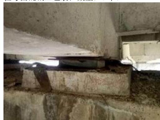
图 3-22: 正兜大桥(下行) 10-10-3 支座: 脱空; 数量: 1 个, 百分比: 50%。
