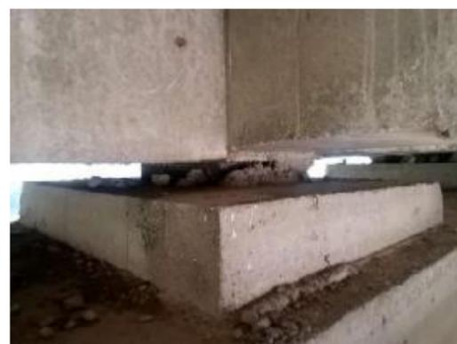
图 3-20: 锦水大桥(下行) 3-3-3 支座: 大桩号面混凝土包裹; 数量: 1 个。
