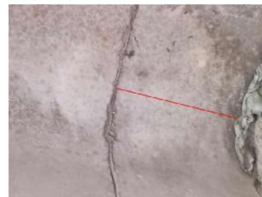
图 3-1：敬长大桥（下行）3-7T 梁：距 2 号墩 0m 处，左翼缘板纵向裂缝；数量：1 条，长度：0.6m，宽度：0.12mm。
