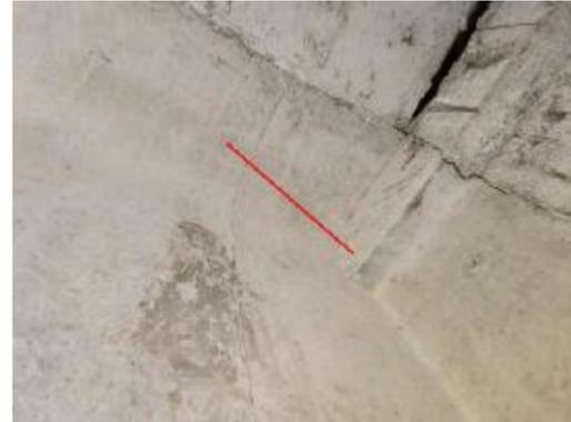
图 3-5: 大坑村分离立交 (上行) 3-5 箱梁: 距 2 号墩 0m 起, 右翼缘板纵向裂缝; 数量: 1 条, 长度: 0.6m, 宽度: 0.12mm。
