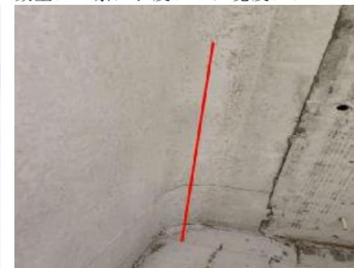
图 3-3: 龙庙大桥 (上行) 1-2T 梁: 距 1 号墩 0m 起, 右侧, 翼板与腹板交接处斜向裂缝; 数量: 1 条, 长度: 0.4m, 宽度: 0.12mm。
