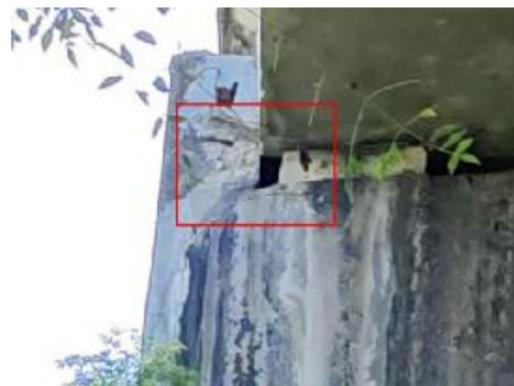
图 3-16: 锦水中桥(上行) GR-3D 盖梁: 距右侧 0m 处, 大桩号面剥落; 数量: 1 处, 长度: 0.15m, 宽度: 0.1m。
