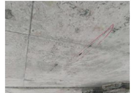
图 3-12: 草埔园互通主线 2 号桥 (下行) 9D1B 箱梁: 距 9 号墩 0.5m 起, 距右侧 6m 处, 梁底露筋; 数量: 1 处, 长度: 0.4m。
