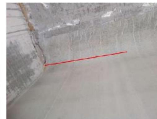
图 3-2：敬长大桥（上行）2-4T 梁：距 2 号墩 0m 处，左侧，翼板与腹板交接处纵向裂缝；数量：1 条，长度：1m，宽度：0.12mm。
