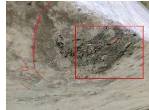
图 3-11: 草埔园互通主线 2 号桥 (上行) 9D1B 箱梁: 距 8 号墩 12m 起, 距右侧 0m 处, 梁底蜂窝、麻面; 数量: 1 处, 长度: 0.2m, 宽度: 0.2m。
