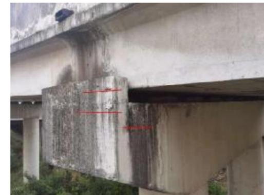
图 3-13: 草埔园枢纽 G 匝道桥 GL-3D 盖梁: 露筋; 数量: 3 处, 长度: 0.3m。
