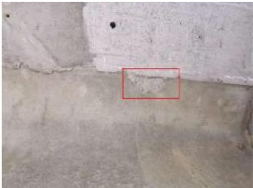
图 3-6: 芸内大桥 (上行) 23-2T 梁: 距 23 号墩 30m 起, 右翼缘板斜向裂缝; 数量: 1 条, 长度: 0.4m, 宽度: 0.12mm。
