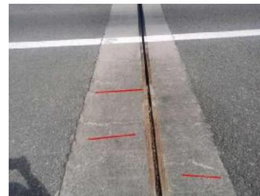
图 3-23: 坝内 1#中桥(上行) 1f 伸缩缝: 距右侧 1m 起, 锚固区开裂; 数量: 3 处, 长度: 0.4m, 宽度: 0.1cm。
