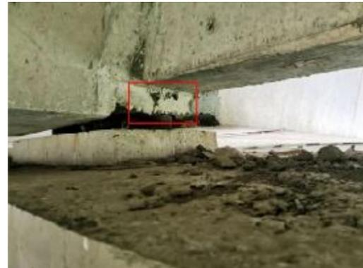
图 3-9: 草埔园互通主线 1 号桥 (下行) 4-1 箱梁: 距 4 号墩 0m 处, 梁底破损露筋; 数量: 1 处, 长度: 0.5m, 宽度: 0.15m。
