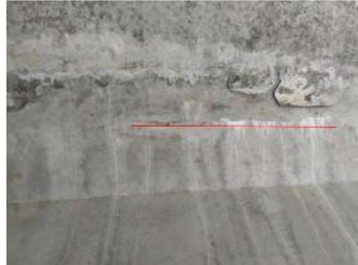
图 3-4: 龙庙大桥 (下行) 1-6T 梁: 距 1 号墩 0m 起, 右翼缘板纵向裂缝; 数量: 1 条, 长度: 1.8m, 宽度: 0.12mm。
